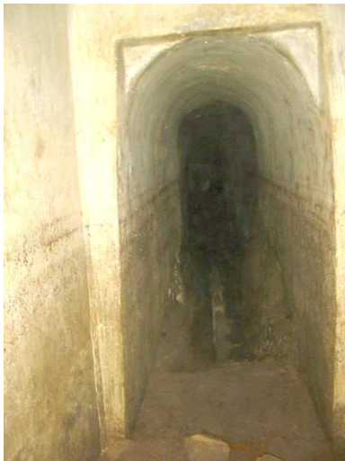
Bild 4 Der Eingangsbereich des Haus Oranien Stollen 2007
