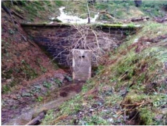
Bild 3 Mundloch des Haus Oranien Stollen 2011
